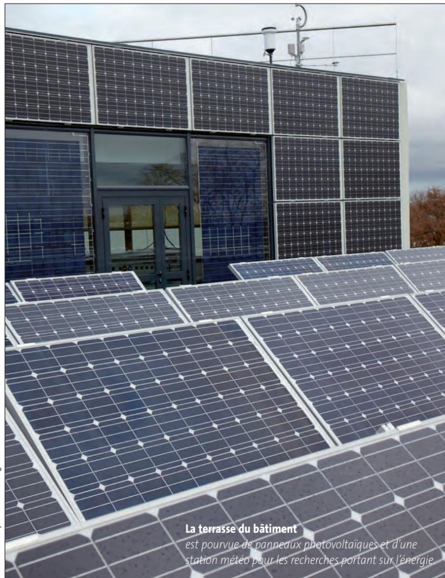
La terrasse du bâtiment est pourvue de panneaux photovoltaïques et d'une station météo pour les recherches portant sur l'énergie.
